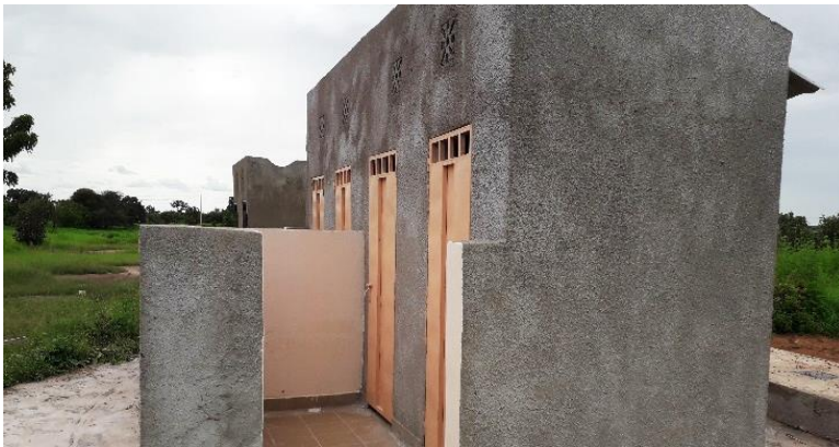
Bloc de 4 toilettes carrelées avec adduction d'eau, pourvues de lavabos
