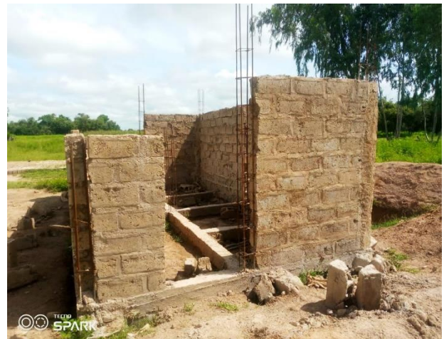
Travaux de fondation du bloc sanitaire de 4 latrines pour l'école élémentaire de Médina Sibikily
